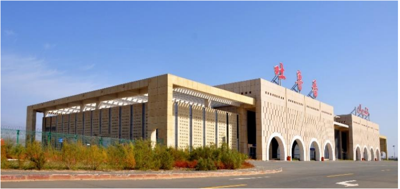
图 B.0.4-1 吐鲁番机场航站楼 将夏季隔热作为设计重点。建筑本体采用了大面积遮蔽、隔热的措施，有效减少了夏天酷日的热辐射。
