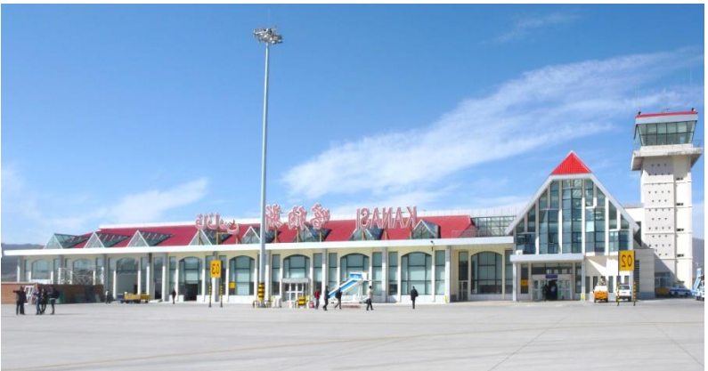
图 B.0.4-2 喀纳斯机场航站楼 阿勒泰地区气候严寒多雪，建筑设计结合气候特点，既利于节能，也使建筑外部形态更加丰富。陡坡屋顶主要是为了减少冬季屋面的积雪。
